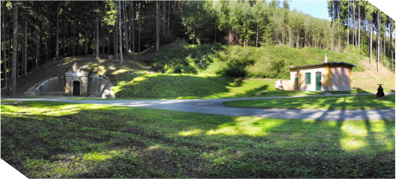
I. březovský vodovod – prameniště
