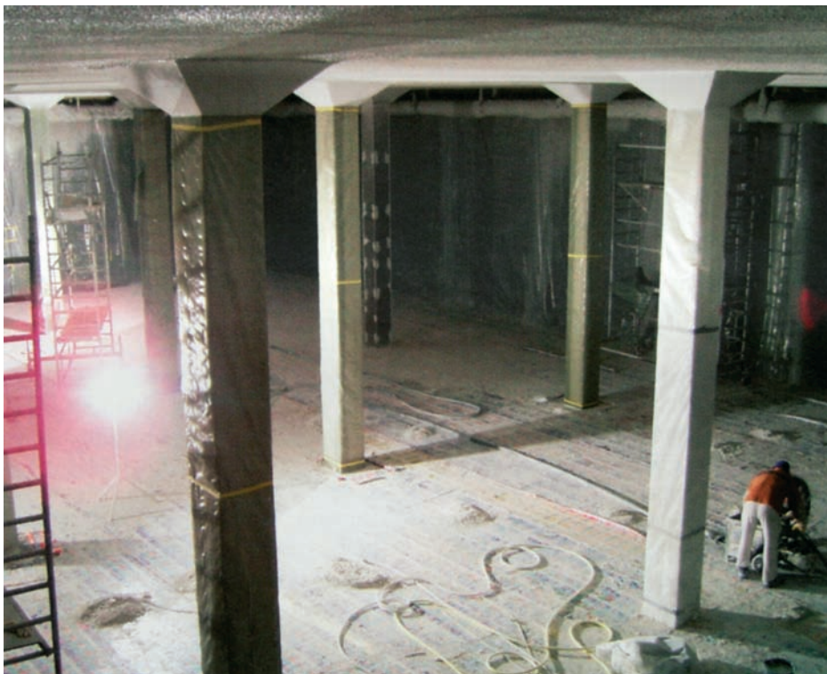
Obr. 3: Pětičlenný tým byl nasazen pro každou komoru. Asi na 6 m vysokých mobilních lešeníh dělníci zpracovávají stropy
