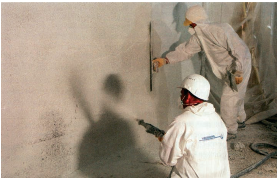
Obr. 4: Pomocí technologického zařízení KERASAL® nanáší pracovník asi 15 mm silnou vrstvu pouze v jediném pracovním kroku
