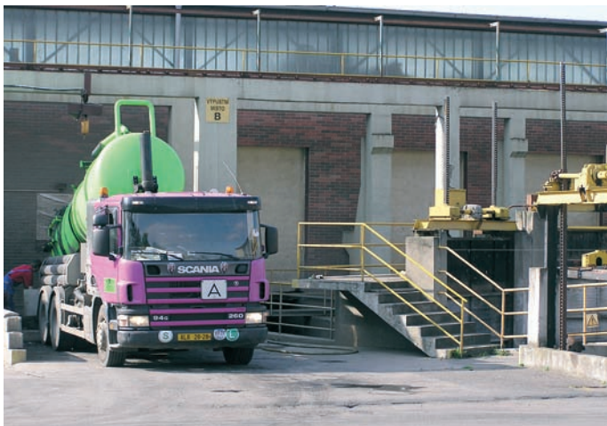
Obr. 2: Výpustní místo „B“
