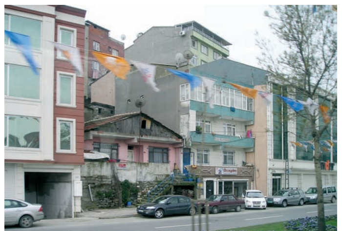
Architektura staveb proti Kongresovému centru je velmi rozmanitá, což je pro Istanbul charakteristické
