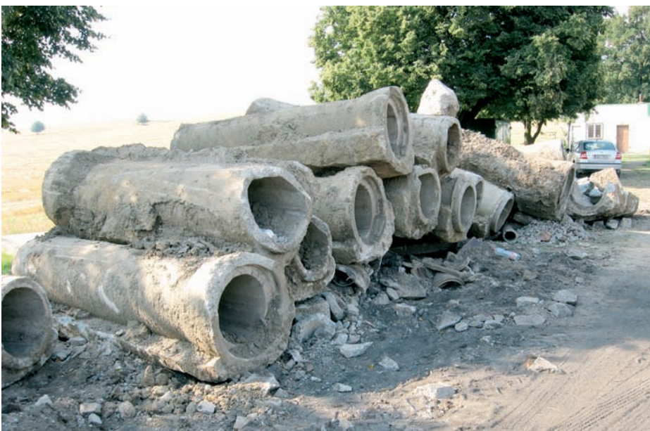
Skládka trub, které byly vykopány při rekonstrukci kanalizace
