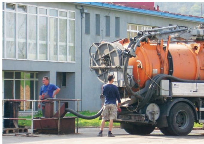
Obr. 3: Výpustní místo „C“
