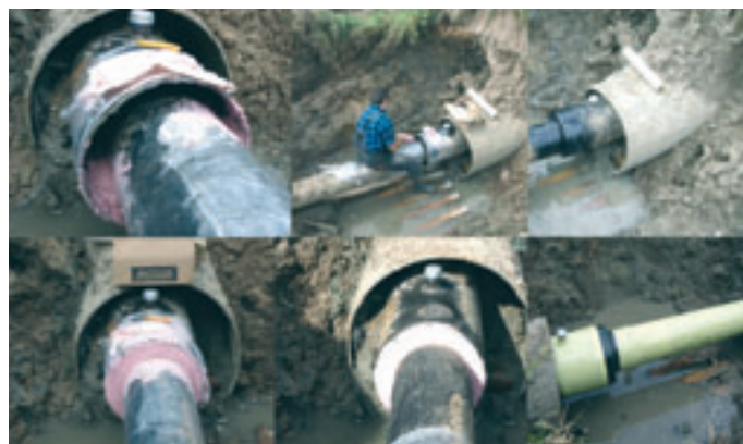
Obr. 10: Těsné uzavření čel před zaizolováním
