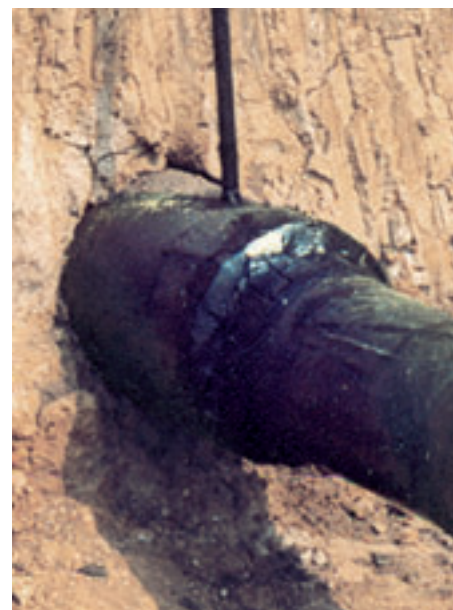
Obr. 2: Standardní provedení čela chráničky s asfaltovým utěsněním. Detail.
