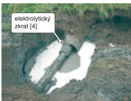
Obr. 5: Elektrolytický zkrat [4]
