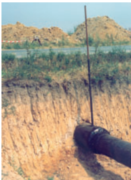
Obr. 2: Standardní provedení čela chráničky s asfaltovým utěsněním. Detail.
