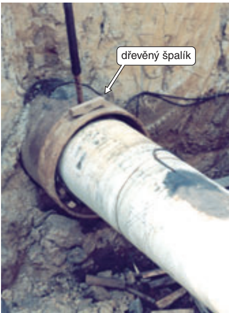
Obr. 3: Vystředění čela chráničky dřevěnými špalíky
