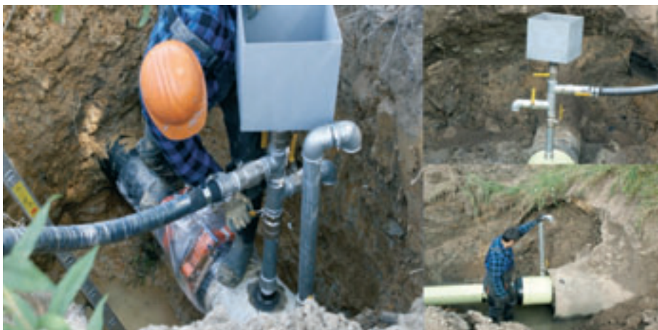
Obr. 7: Uzamčení konců ochranných trubek
