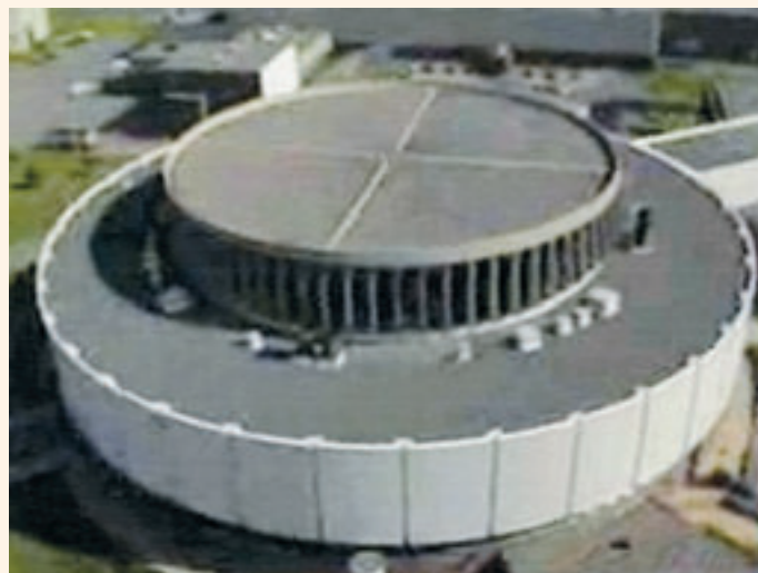
Centrální čerpací stanice na ČOV Jean-R. Marcotte
