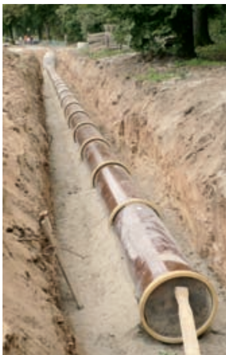
Bakov nad Jizerou – pokládka kanalizační stoky
