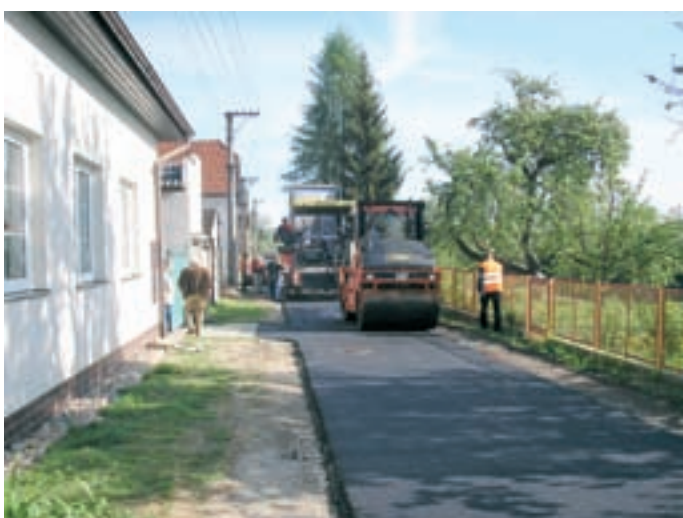
Benátky nad Jizerou, oprava komunikace po výstavbě kanalizace
