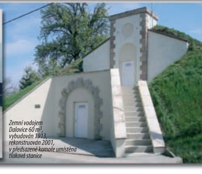
Zemní vodojem Písková Lhota 100 m 3 , vybudován 1964, rekonstruován 2006, v přízemí umístěna tlaková stanice
