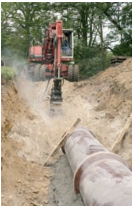
Bakov nad Jizerou – rozpojování skalního podloží skalní frézou
