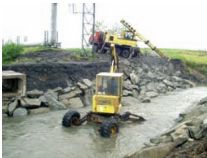
Přemostění Mlýnky – provizorní levobřežní opevnění
