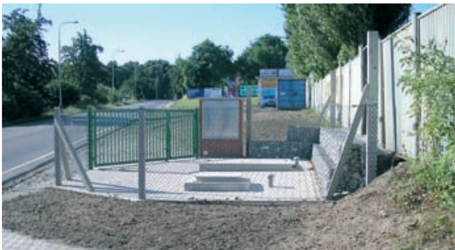
Kosmonosy, čerpací stanice odpadních vod, vpravo armaturní šachta
