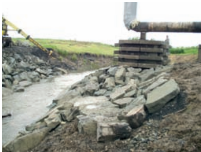
Přemostění Mlýnky – provizorní pravobřežní opevnění
